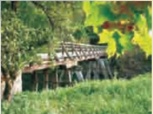
Die Pfahljochbrücke, eine der ältesten erhaltenen Holzbrücken im süddeutschen Raum
